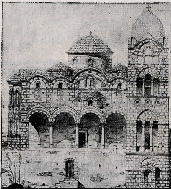
FIG. 28. - Pantanassa. Façade Nord et clocher.
